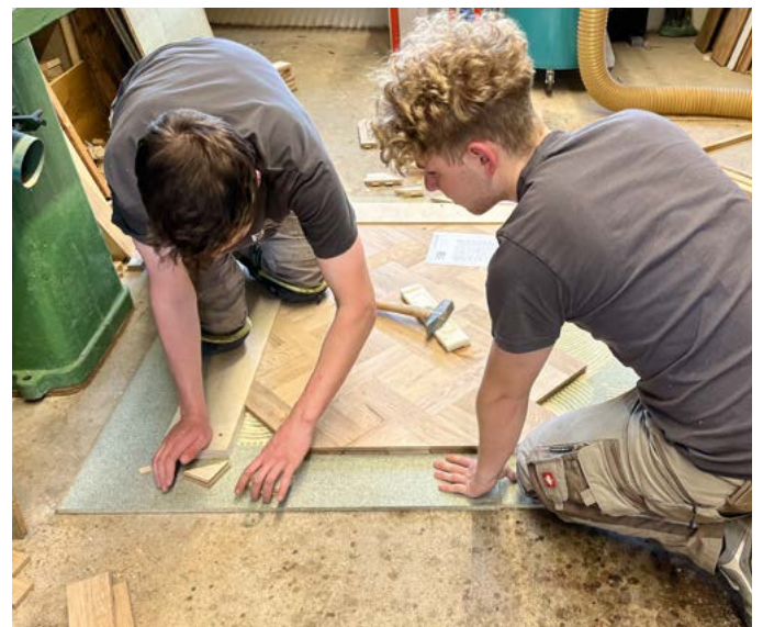
Vor der Gesellenprüfung werden die Azubis durch die beiden Parkettlegermeister Felix Bauer und Regina Fraunhofer gecoacht.
